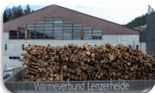
Heizzentrale des Wärmeverbunds
