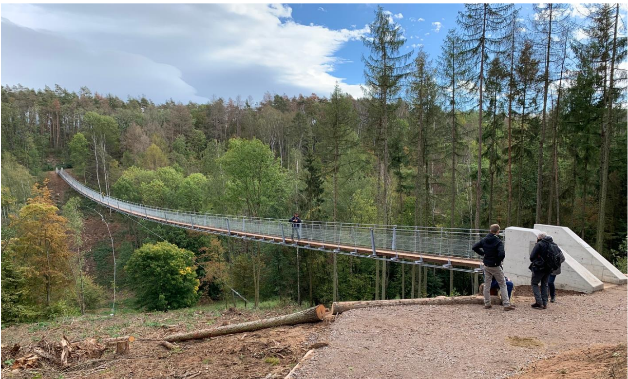
Beispiel Hängebrücke Greina mit minimalem Widerlager.
