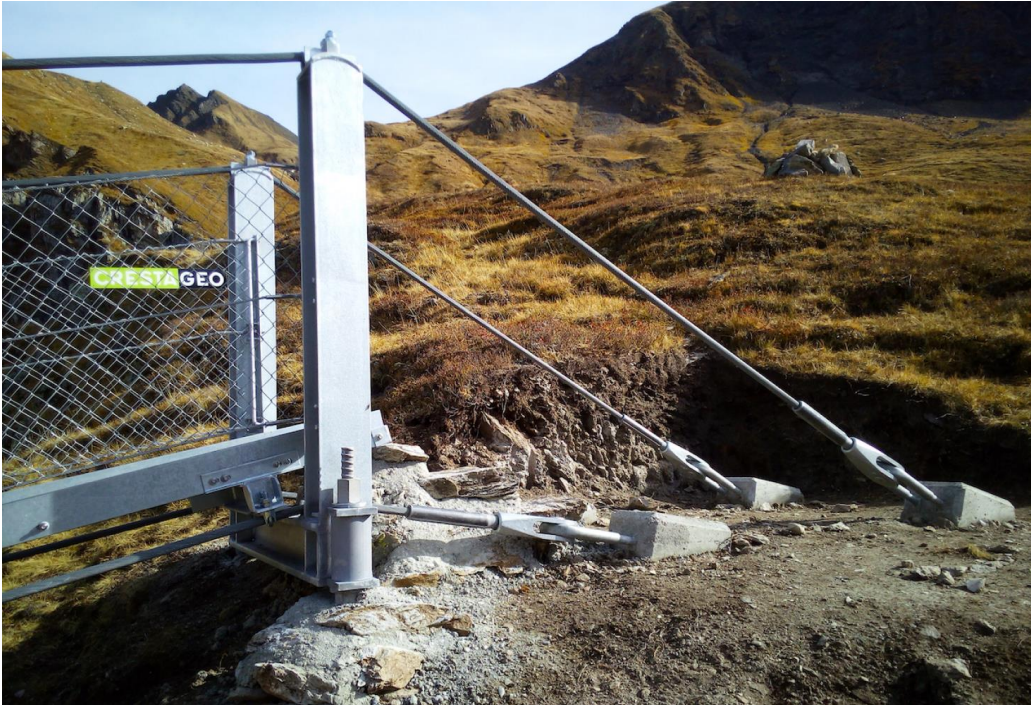
Beispiel Hängebrücke Greina mit minimalem Widerlager.
